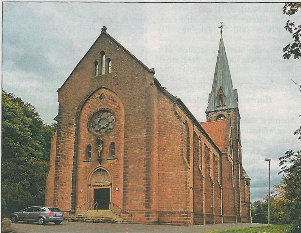
Erstrahlt nach umfangreichen Sanierungsarbeiten in neuem Glanz: die 110 Jahre alte Jakobuskirche in Breitenbach. Foto: Stirnemann
